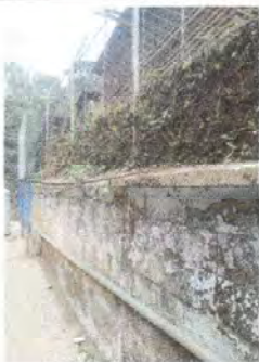
Foto1: Mantenimiento HG y malla galvanizada
