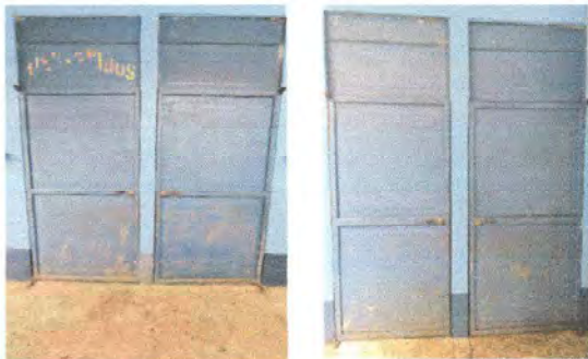
Foto1: Puerta de aulas
